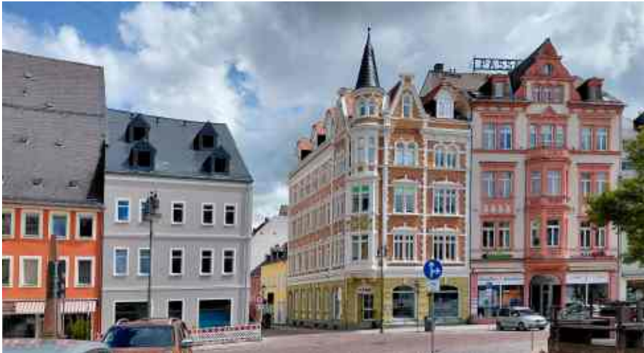
Blick auf die Ostseite des Mittweidaer Marktes: Das Erdgeschoss des sanierten Gebäudes Markt 14 soll bald das neue Domizil von Ernstings Family werden. Foto: Uwe Schönberner
